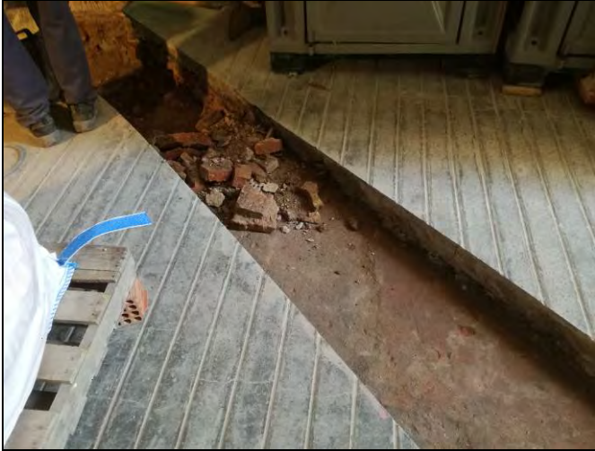
Foto 49. Rasa 700. Desmantellament del paviment UE 1002.
