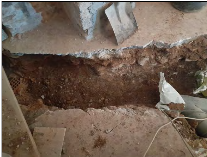
Foto 99. Desmuntatge parcial del mur UE 1100.
