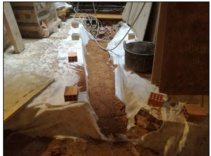
Foto 92. Rebliment d'estructures a la rasa 600.
