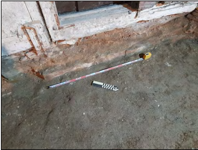
Foto 61. Cala 300. Mur UE 1085.
