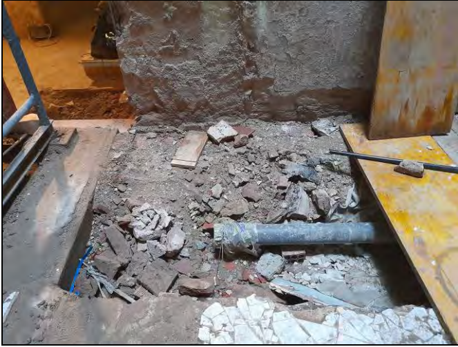
Foto 81. Cala 400. Estat inicial.
