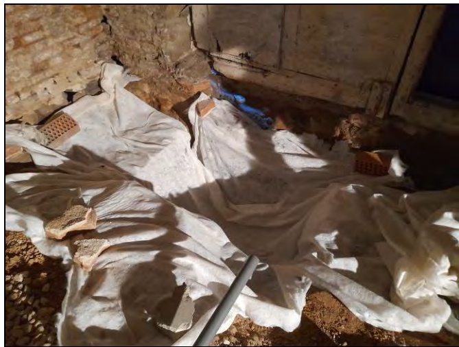
Foto 95. Rebliment d'estructures a la cala 300.
