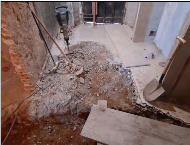
Foto 83. Inici del rebaix al vestíbul de l'escala.
