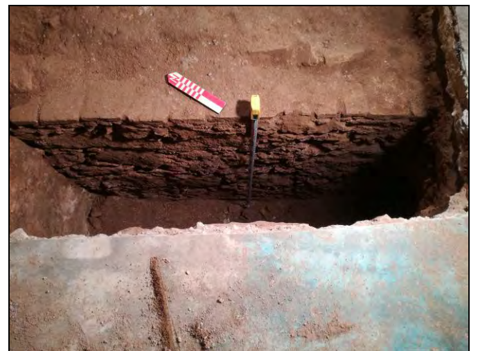
Foto 24. Cala 100. Fonamentació UE 1007.
