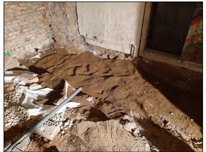
Foto 96. Rebliment d'estructures a la cala 300.
