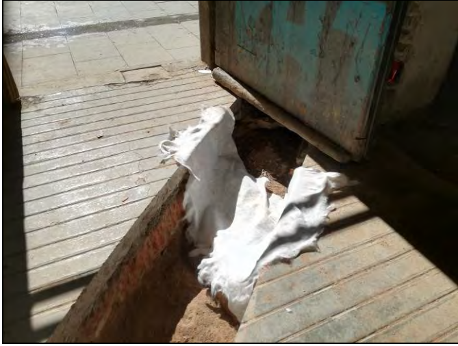
Foto 93. Rebliment d'estructures a la rasa 700.
