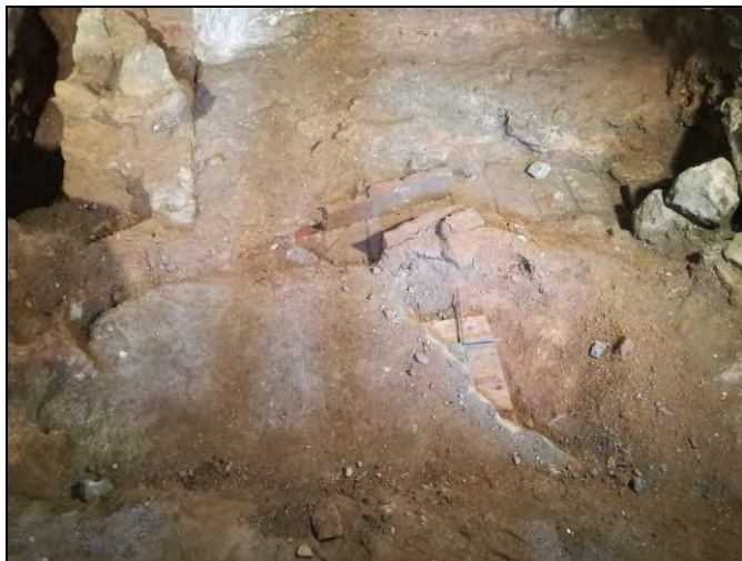
Foto 35. Cala 200. Taulons d'encofrar sota el formigó armat.
