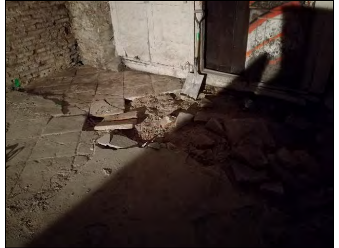
Foto 54. Cala 300. Desmantellament del paviment UE 1002.
