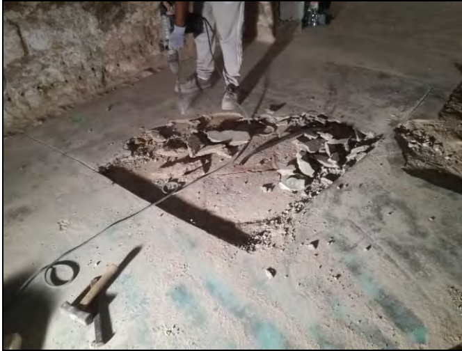
Foto 17. Cala 100. Desmantellament del paviment UE 1001.
