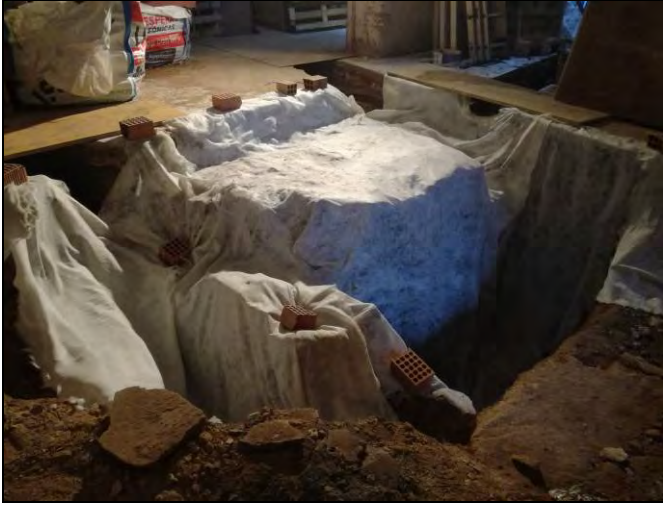
Foto 89. Rebliment d'estructures a la cala 200.
