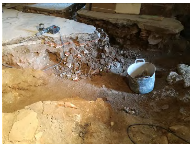
Foto 27. Cala 200. Desmantellament de paviments.
