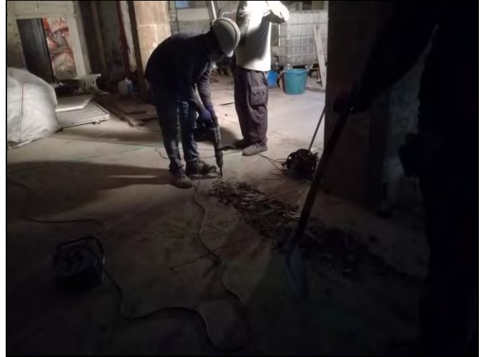
Foto 66. Obertura de les rases.
