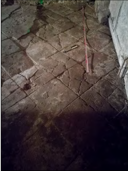
Foto 53. Cala 300. Paviment UE 1002.
