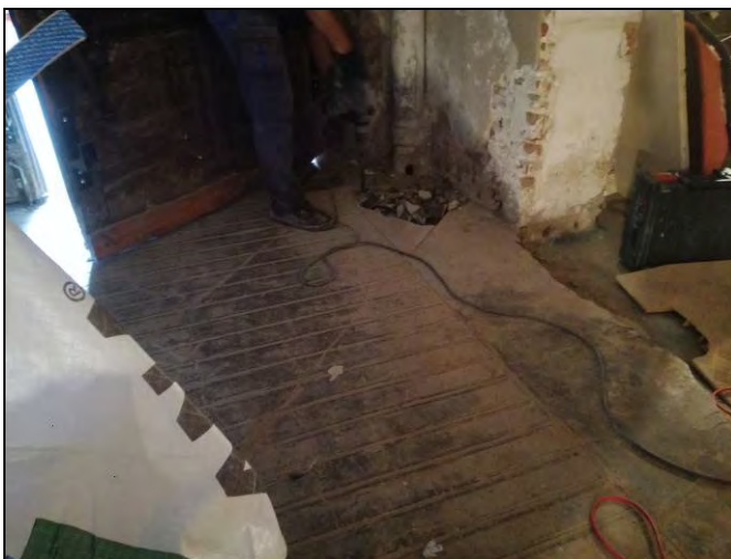
Foto 47. Obertura de la rasa 700.
