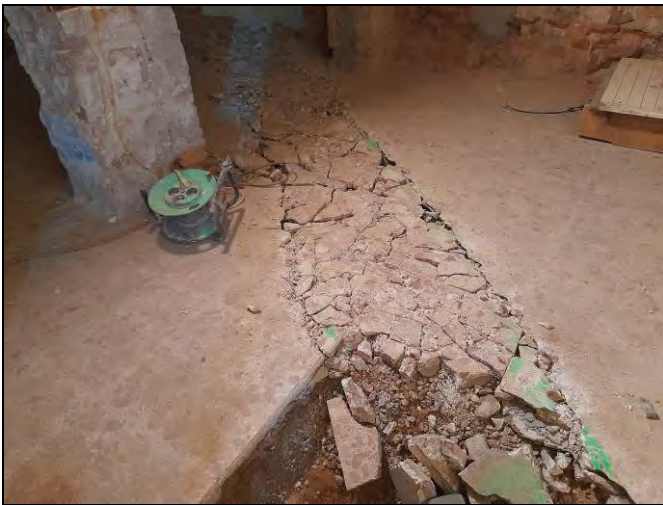
Foto 67. Obertura de les rases.
