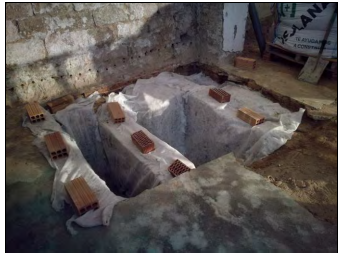
Foto 86. Rebliment d'estructures a la cala 100.
