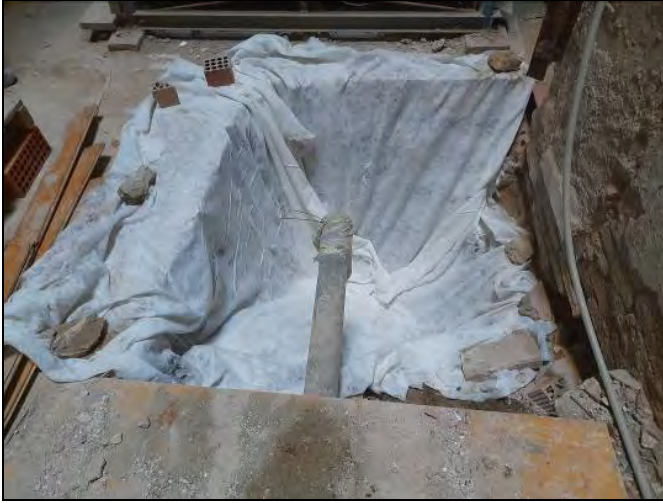
Foto 97. cobertura amb geotèxtil d' estructures a la cala 400.
