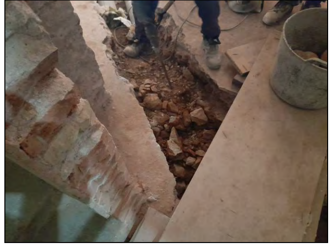
Foto 98. Desmuntatge parcial del mur UE 1100.
