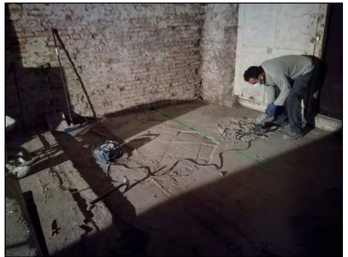
Foto 52. Cala 300. Desmantellament del paviment UE 1001.
