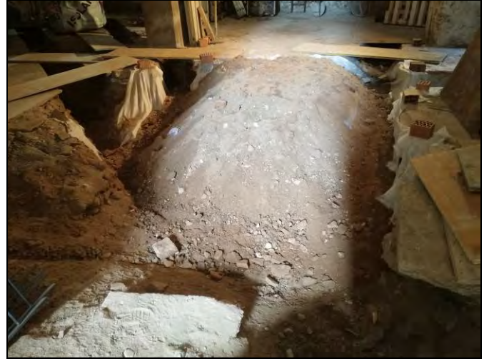
Foto 90. Rebliment d'estructures a la cala 200.
