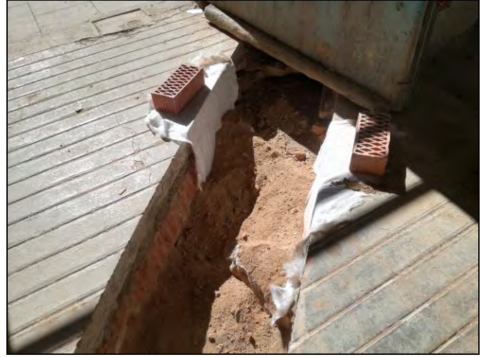
Foto 94. Rebliment d'estructures a la rasa 700.
