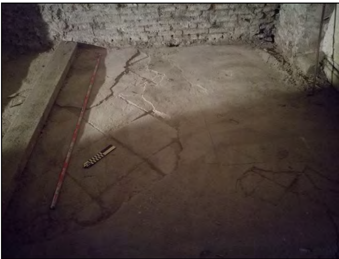
Foto 51. Cala 300. Paviment UE 1001 cobrint el paviment UE 1002.
