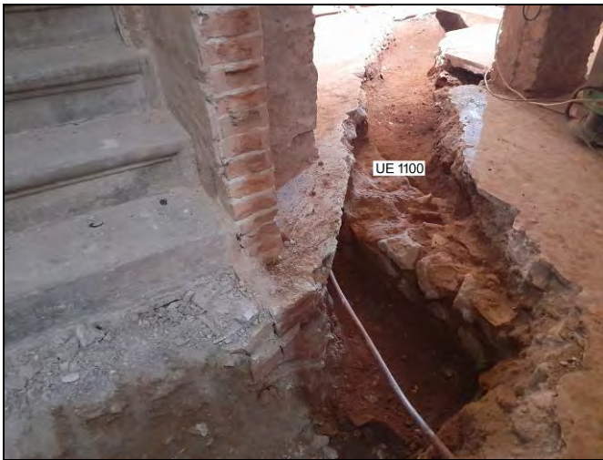
Foto 75. Rasa 1700 amb el mur UE 1100.
