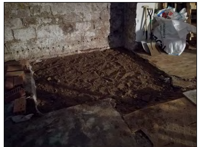
Foto 88. Rebliment d'estructures a la cala 100.
