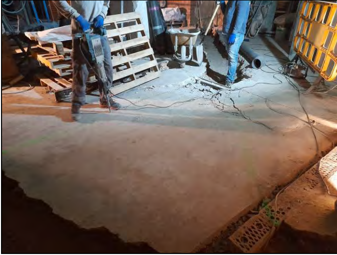
Foto 65. Obertura de les rases.
